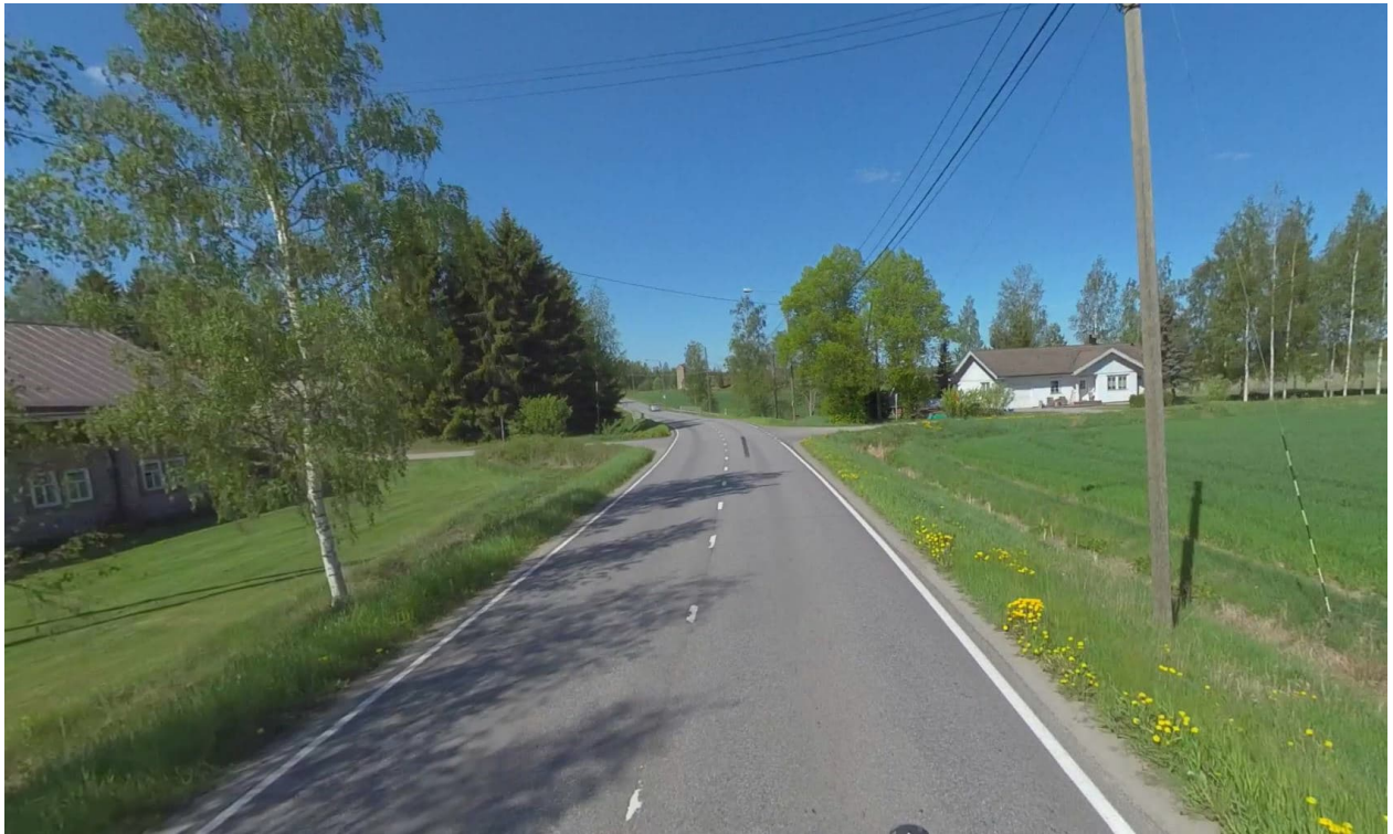
Kuva 4 Hujalantie (Mt12254), Vahdontien kiertoliittymästä noin 100m lännen suuntaan (Google 2020)
