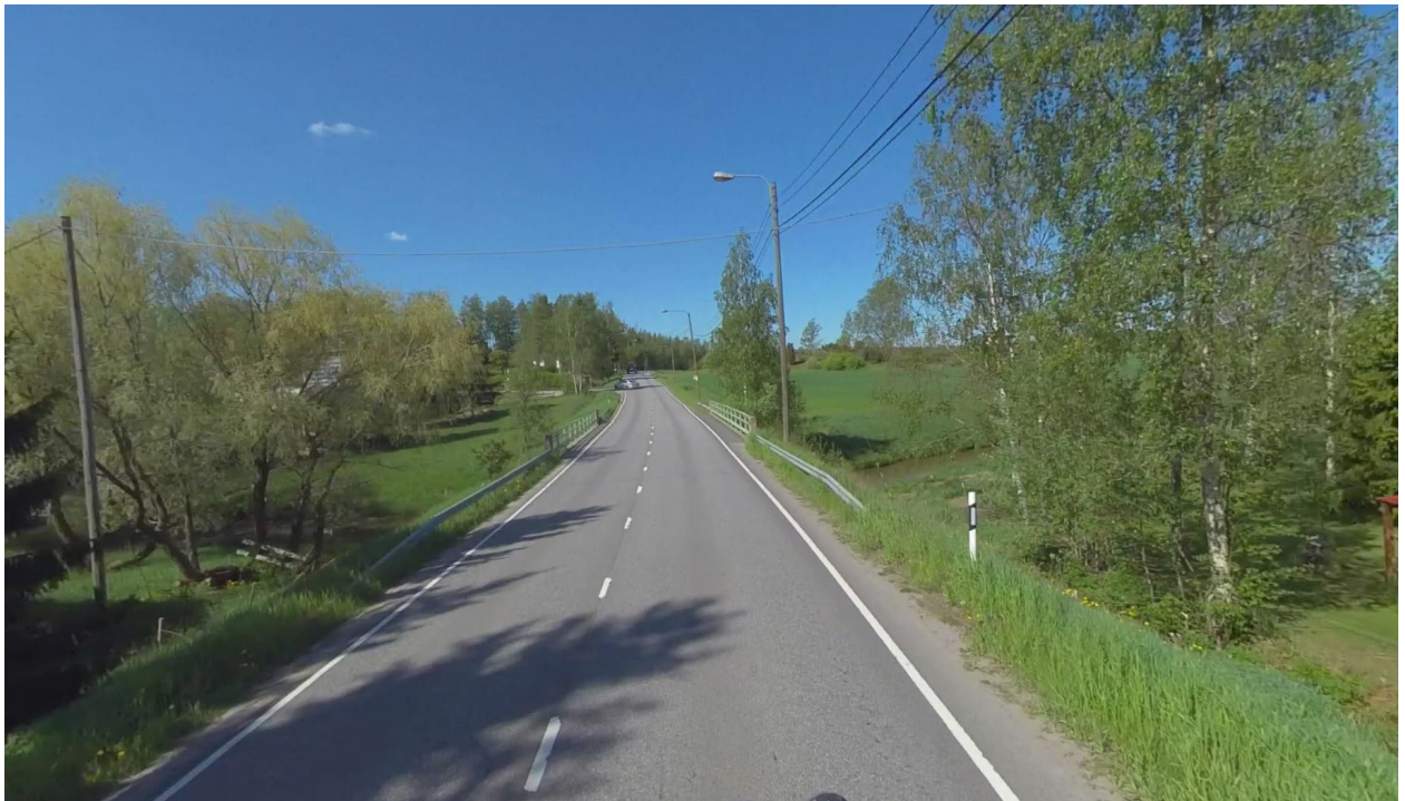
Kuva 5 Hujalantie (Mt12254), Munittulan sillan kohdalla (Google 2020)
