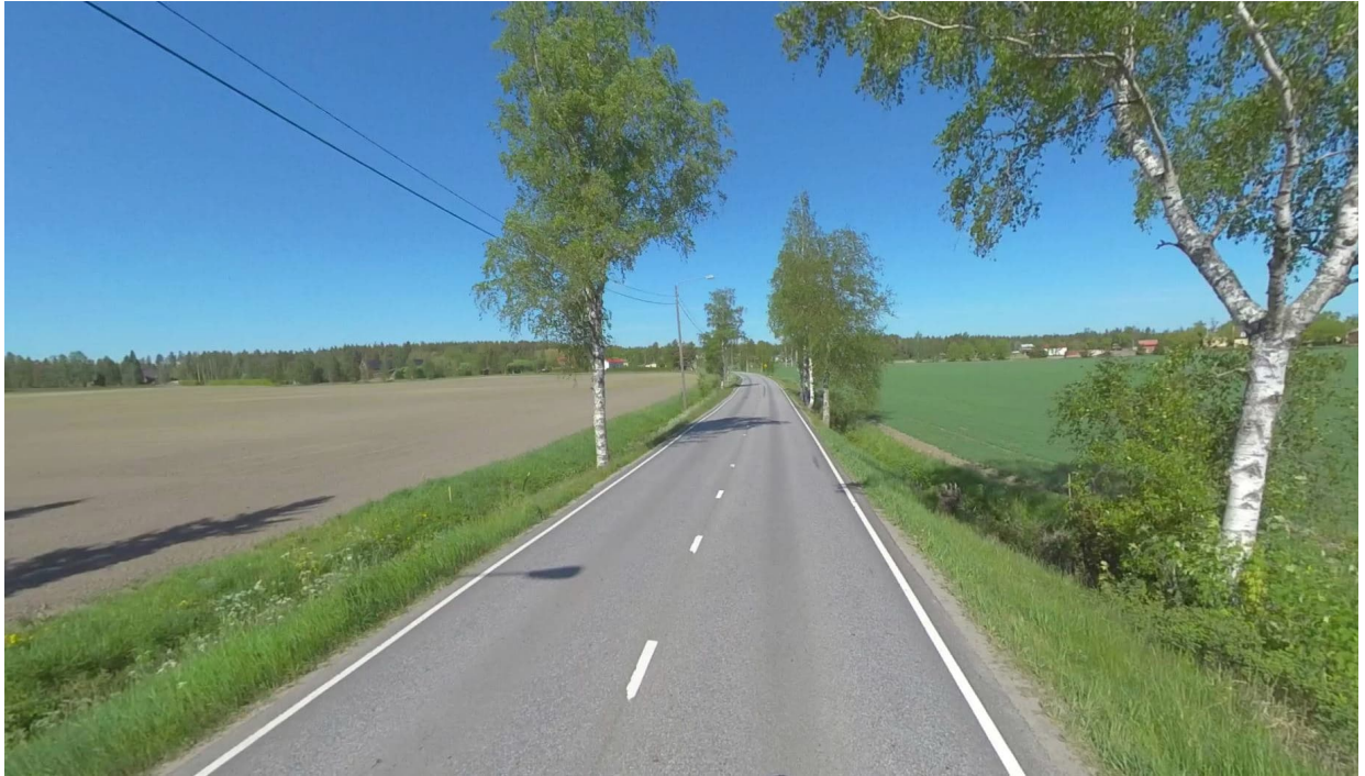
Kuva 6 Hujalantie (Mt12254), Vahdontien kiertoliittymästä noin 700m lännen suuntaan (Google 2020)
